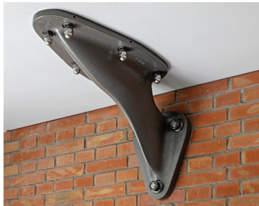
Die Verbindungselemente aus Sphäroguss im Innenraum
