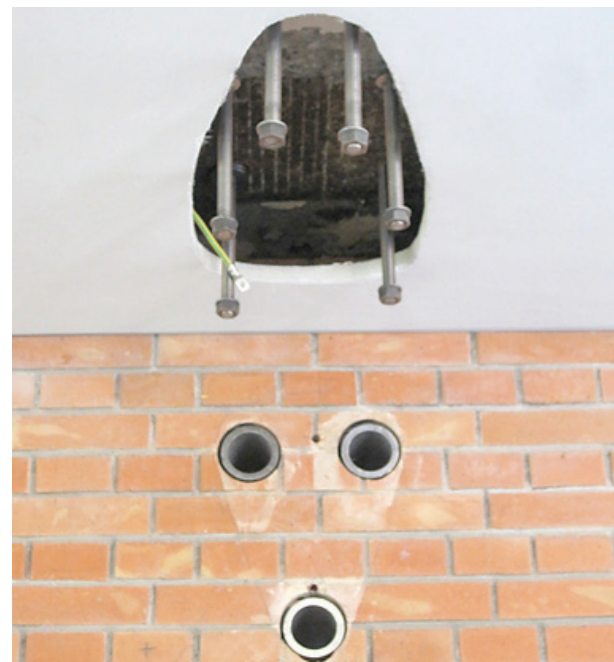
Montage der Gussteile
