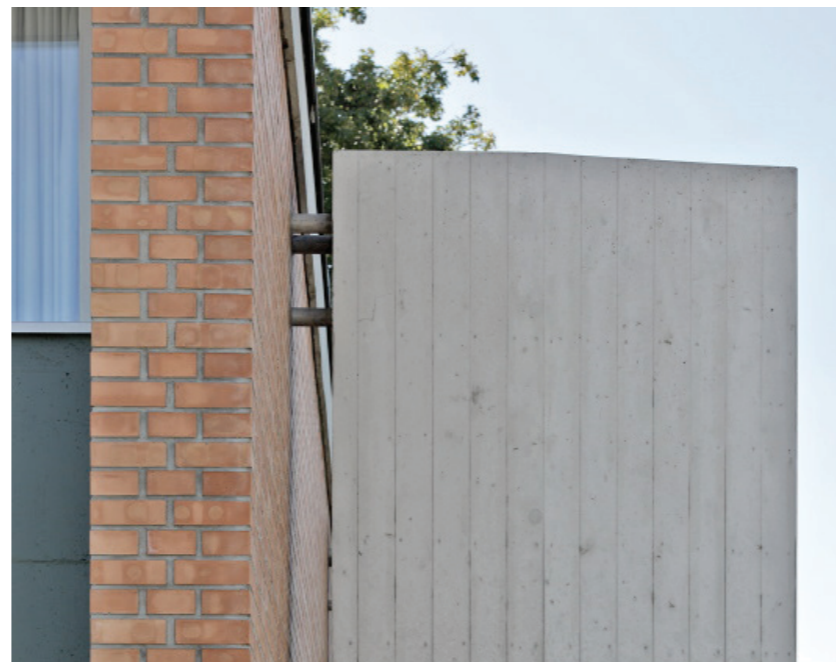
Die Betonpfeiler an der Westfassade
