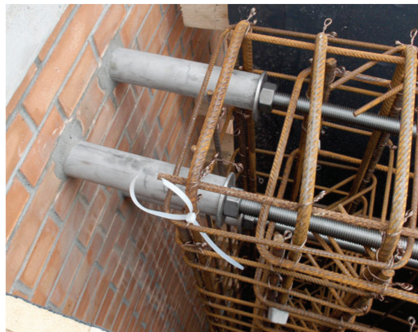
Armierung der Aussenpfeiler
