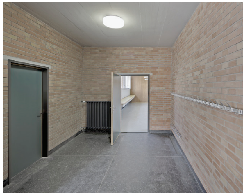
Die Innenräume nach der Sanierung
