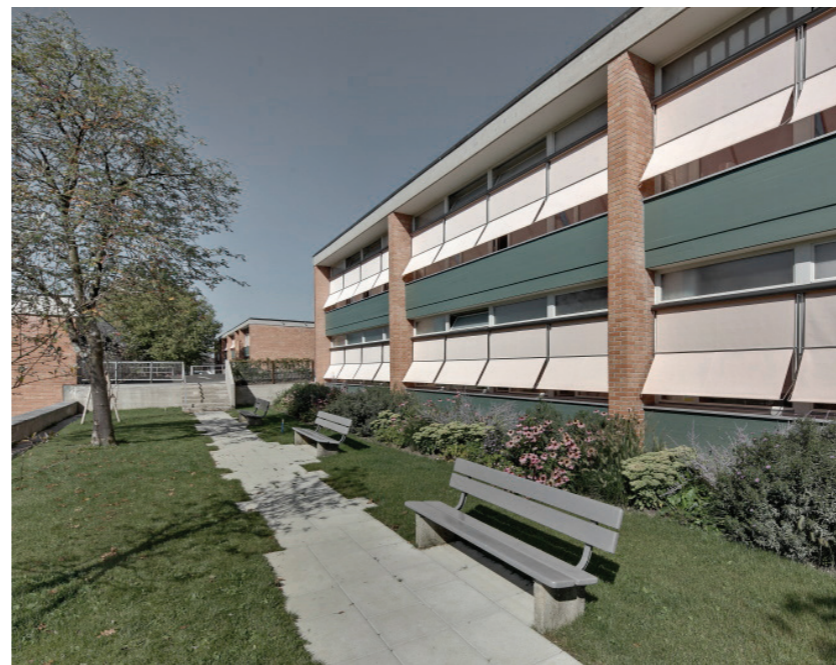
Die Aussenräume nach der Sanierung
