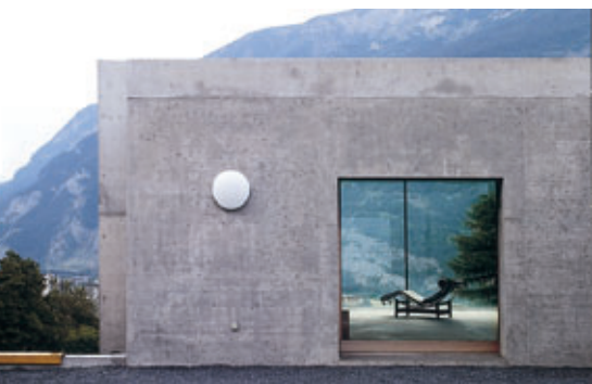
Monolithisch in Dämmbeton: Wohnhaus Gartmann in Chur
