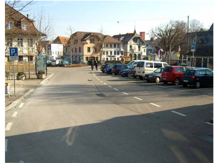
Wuhrplatz vor der Neugestaltung
