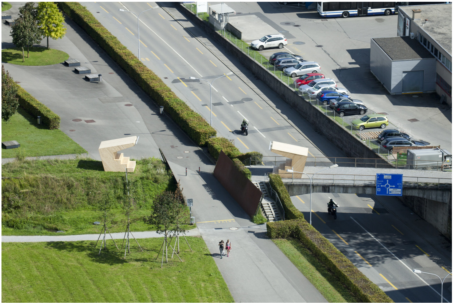
Die beiden Tribünen stehen sich gegenüber, getrennt durch den Fussweg.
