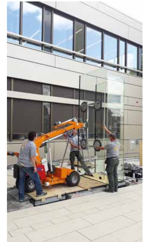
31.07.2019 Montage der Glasstelen
