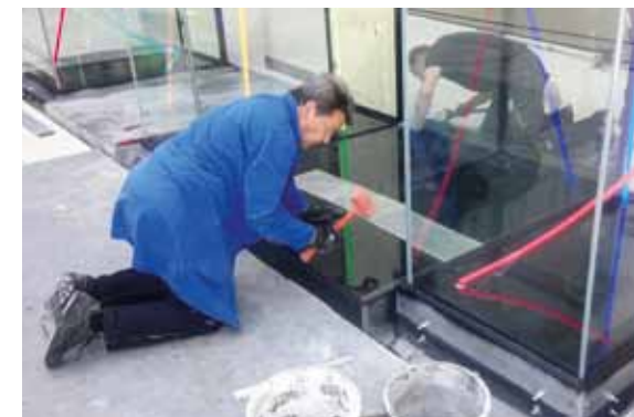
21.08.2019 Verlegung des Granitsockels
