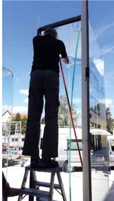
08.08.2019 Montage der Neonröhren
