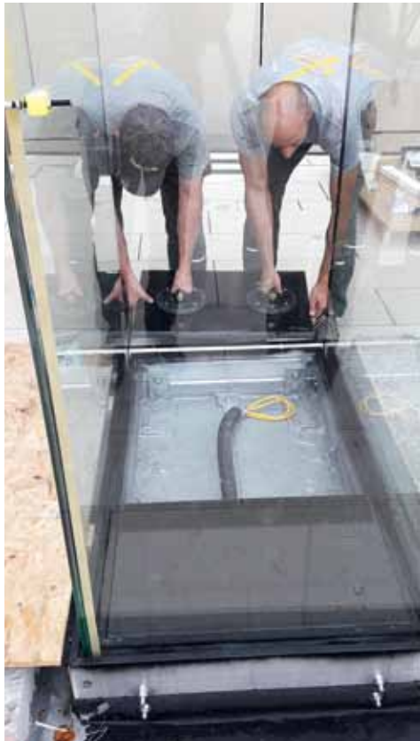
31.07.2019 Montage der Glasstelen und Verlegung des Granit-Doppelbodens
