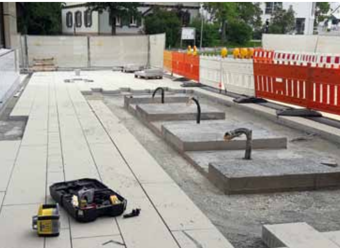
07.06.2019 Fundament mit Leerrohren für die Elektroinstallation
