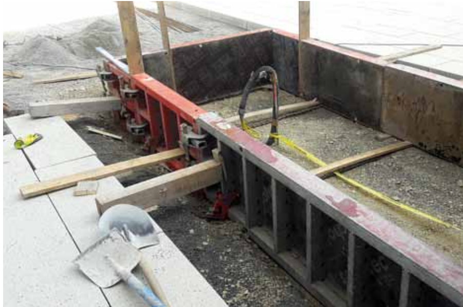
07.06.2019 Fundament mit Leerrohren für die Elektroinstallation
